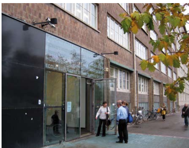
Kuva 1. Esimerkkikorkeakoulun pääsisäänkäynti Hämeentiellä. (Kuva: JS)
