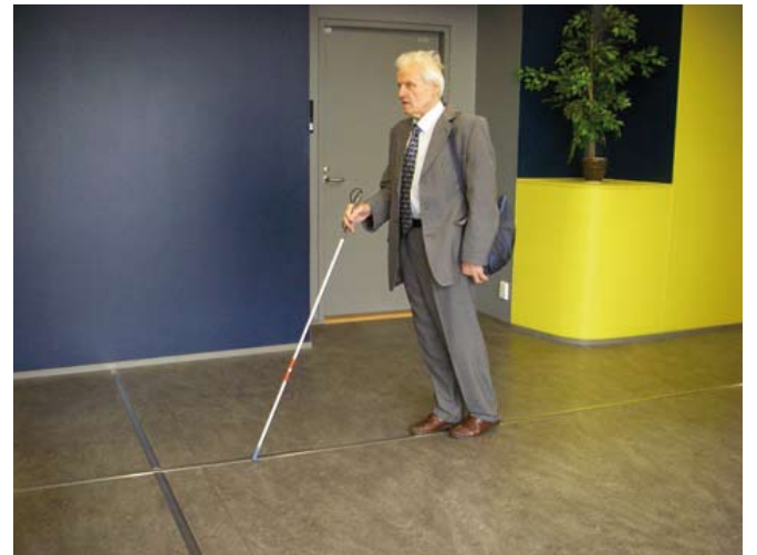
Kuva 28. Jatkuva metallilistaa on helppo seurata valkoisella kepillä. (Näkövammaisten palvelu- ja toimintakeskus Iiris, Helsinki. Kuva: JS)
