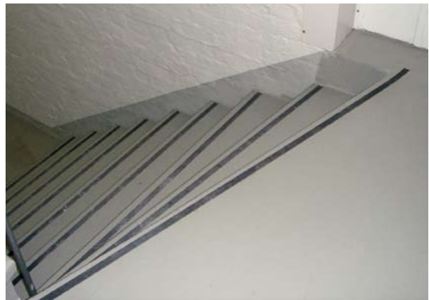
Kuva 9. Porrasaskelmissa on hyvät kontrastimerkinnot, mikä auttaa havaitsemaan myös portaan muuttuvan muodon. (Kuva: AR)
