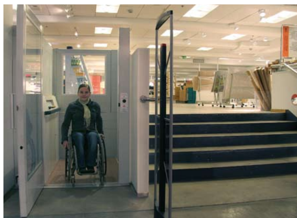
Kuva 69. Esteetön kulkuyhteys kerrostasenteelta toiselle on järjestetty pystyhissillä. (Stockmann, Helsinki. Kuva: JH)
