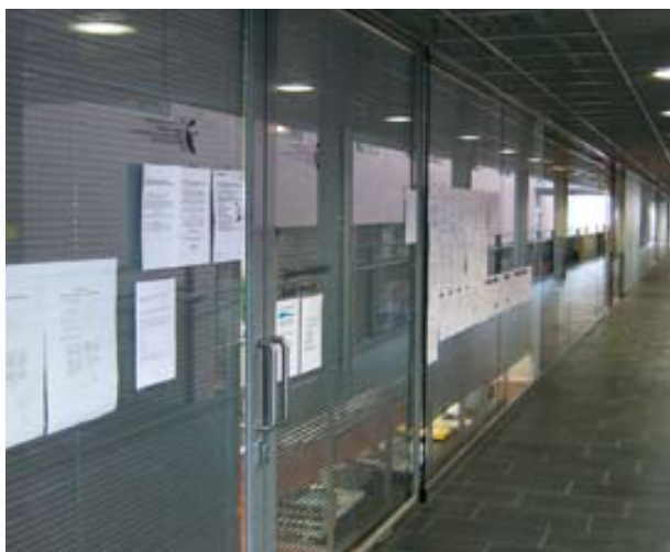
Kuva 38. Sisäänkäyntiä on vaikea hahmottaa lasiseinästä. Kuva: JS)
