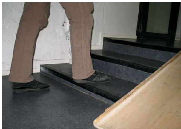
Kuva 37. Portaiden nousu vaihtelee. (Kuva: AR)
