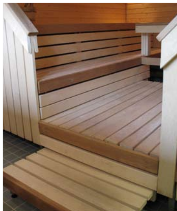
Kuva 85. Saunan lauteiden ja lauteille johtavien portaiden hahmottumista auttaa tummuus-kontrastina erottuva reunalauta. (Lomakoti Haapalahti, Eno. Kuva: AR)
