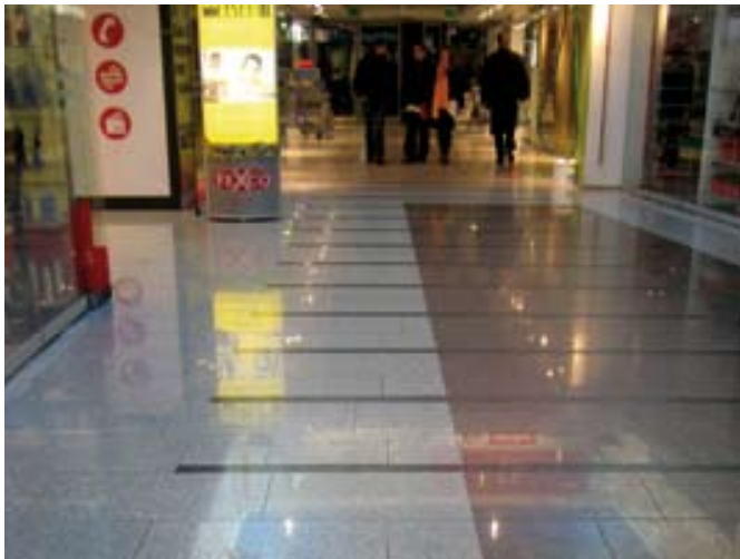
Kuva 27. Voimakkaat kuvioinnit ja kiiltävä lattia tekevät liikkumisesta epävarmaa. (City-käytävä, Helsinki. Kuva: AR)
