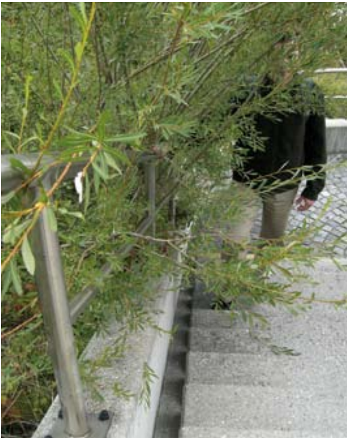
Kuva 38. Hoitamaton kasvillisuus estää ulkoportaiden käsijohteen käytön ja aiheuttaa törmäysvaaran. (Augsburg, Saksa. Kuva: AR)
