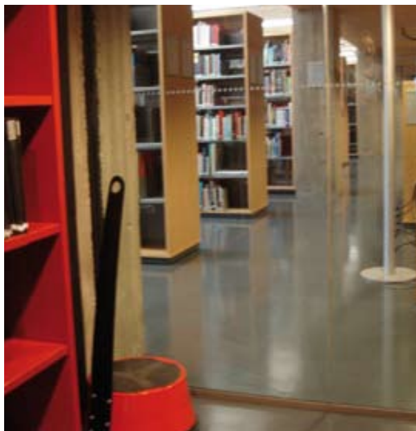
Kuva 33. Lukusalin lasiseinän kontrastiraita ei ole riittävä. (Kuva: NK)
