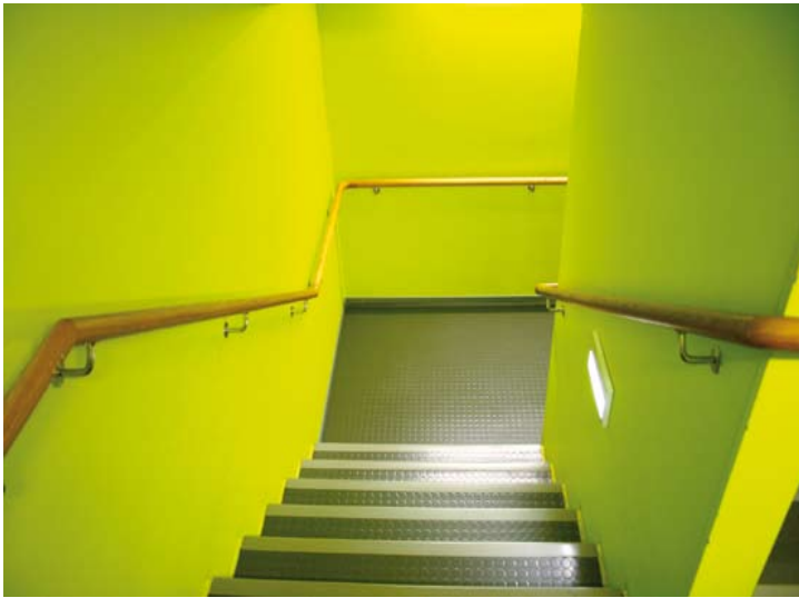
Kuvat 13 ja 14. Värikuvan mustavalkoisesta versiosta näkee, että porrasaskelmien kontrastiraidat ja käsijohteet erottuvat tummuuskontrastina taustastaan. (Näkövammaisten palvelu- ja toimintakeskus Iiris, Helsinki. Kuva: JS)
