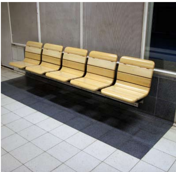
Kuva 71. Istuimet on sijoitettu kulkureitin sivuun ja alue sekä istuimet erottuvat tummuuskontrastina. (Kaisaniemen metroasema, Helsinki. Kuva: JH)
