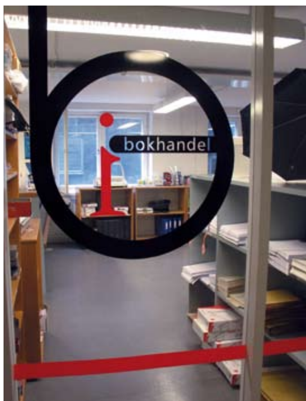
Kuva 56. Tarramerkintä toimii selkeänä kontrastimerkintä lasiseinässä ja ovesta. (Svenska Handelshögskolan, Helsinki. Kuva: AR)
