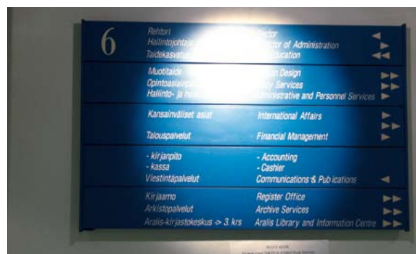
Kuva 7. Kerrosopasteen pistemäinen valaisin aiheuttaa häikäisyä ja jättää osan tekstistä varjoon. (Kuva: AR)
