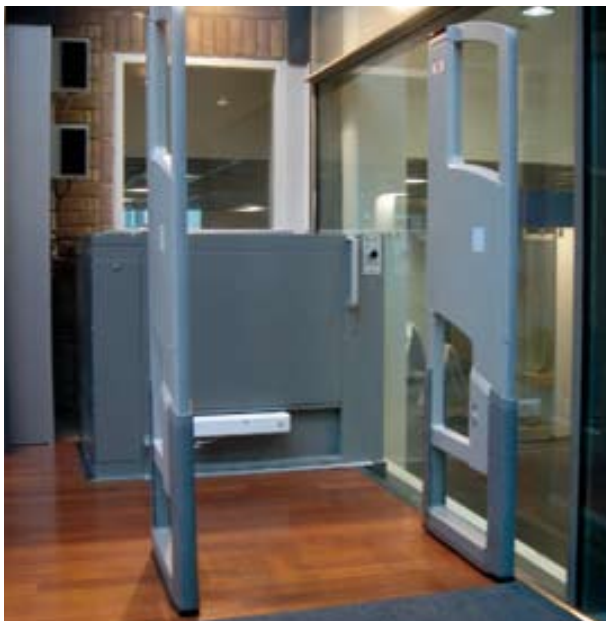
Kuva 30. Pystyhisinn edessä ei ole tarpeeksi vapaata tilaa. (Kuva: AR)
