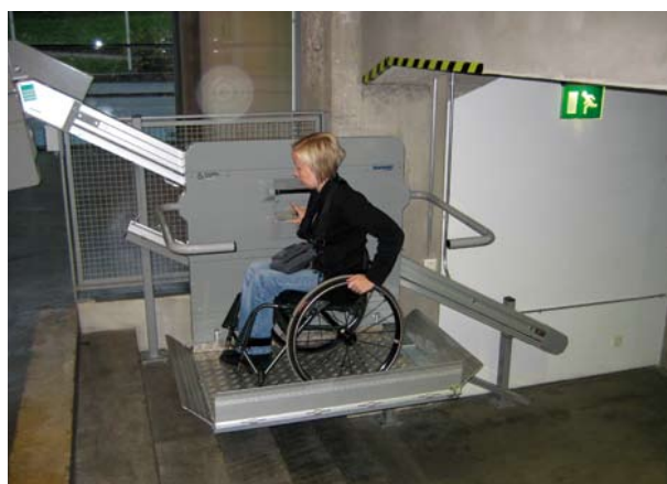
Kuva 70. Tätä porrashissiä voi käyttää itsenäisesti. Kuvan hississä vapaa korkeus jää kuitenkin alle vaaditun ja törmäysvaarasta varoitetaan huomioteippauksella. (Taideteollinen korkeakoulu, Helsinki. Kuva: JS)
