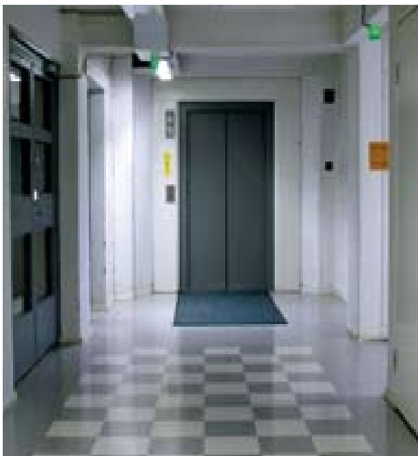
Kuva 15. Hissin 19 ovi erottuu tummuuskontrastina seinästä. (Kuva: AR)
