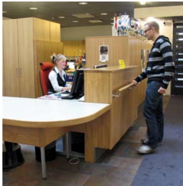
Kuva 74. Palvelutiskillä voi asioida sekä seisoma- että istuinkorkeudella. (Invalidiliiton esteetön toimitalo, Helsinki. Kuva: AR)
