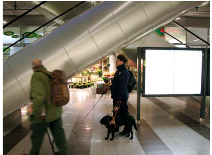
Kuva 11. Näkövammaisen henkilö voi lyödä päänsä portaaseen, jota ei voi havaita valkoisella kepillä. (Kampin kauppakeskus, Helsinki. Kuva: JH)
