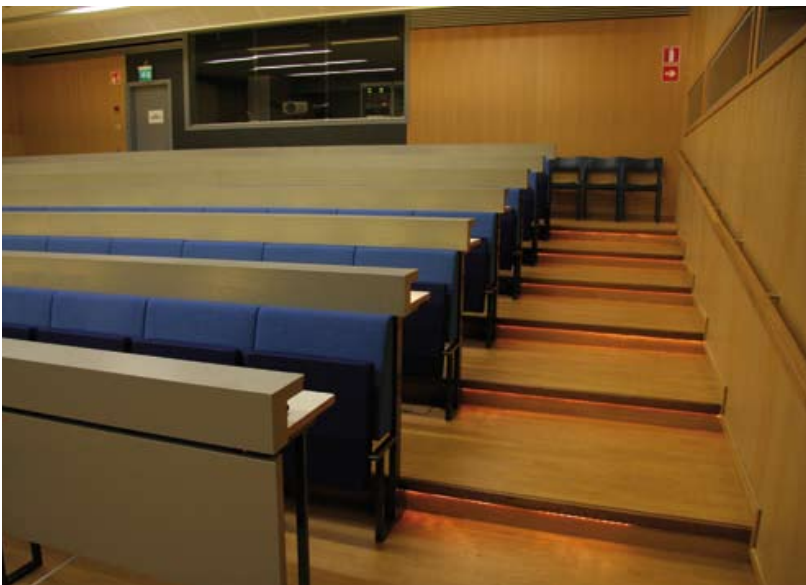
Kuva 62. Auditorion porrasaskelmat on valaistu niin, että ne erottuvat myös salin ollessa pimennetty. (Näkövammaisten palvelu- ja toimintakeskus Iiris, Helsinki. Kuva: JH)
