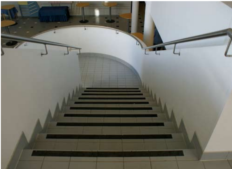
Kuva 61. Kontrastiraita porrasaskelman reunassa auttaa portaiden hahmottamisessa. Käsiyhteys on yhtenäinen ja jatkuu välitasanteella. (Valkea talo, Helsinki. Kuva: JS)
