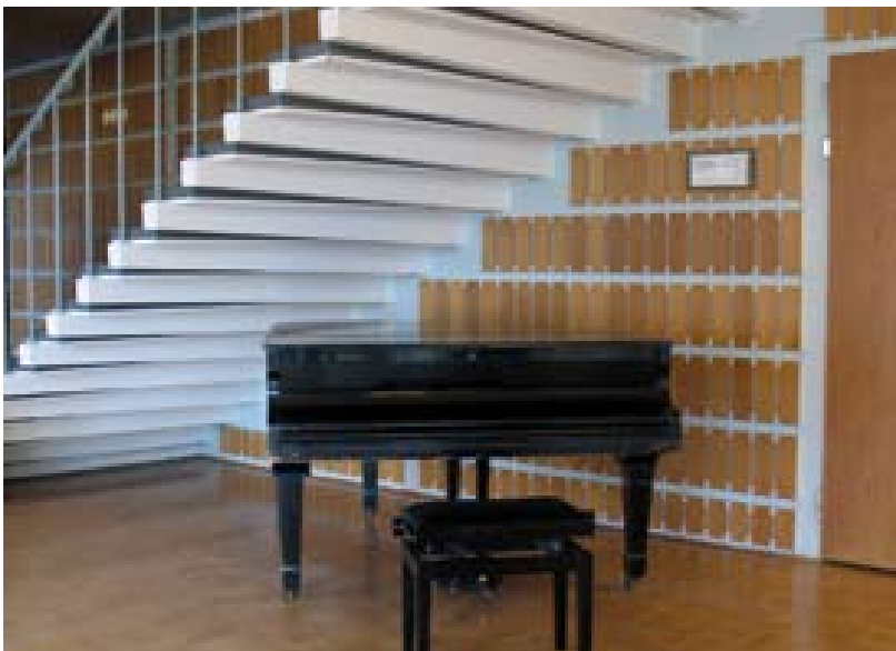
Kuva 63. Kekseliäs idea estää törmääminen portaisiin on sijoittaa portaiden alle flyygeli. Flyygeli ei tosin estä portaalle joutumista sivusuunnasta, mutta idea on hyvä. (Svenska Handelshögskolan, Helsinki. Kuva: AR)
