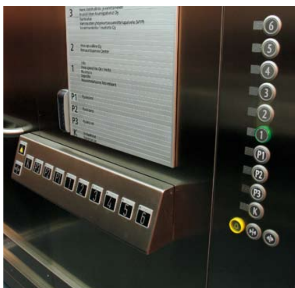
Kuva 68. Hissin vaakasuora ja pystysuora ohjauspaneeli mahdollistavat kerrospainikkeen painamisen eri korkeuksilta. (Invalidiliiton esteetön toimitalo, Helsinki. Kuva: AR)
