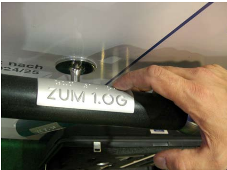
Kuva 66. Käsijohteen pintaan pistekirjoituksella ja kohonumeroilla merkityn kerrosnumeron voi lukea sormin. (Augsburg, Saksa. Kuva: AR)
