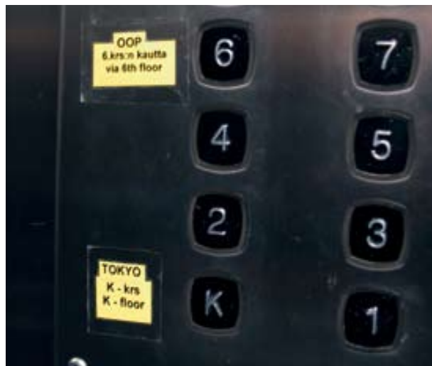
Kuva 16. Ohjauspaneeliin kerrospainikkeiden viereen lisätyt tekstit eivät erotu. (Kuva: AR)
