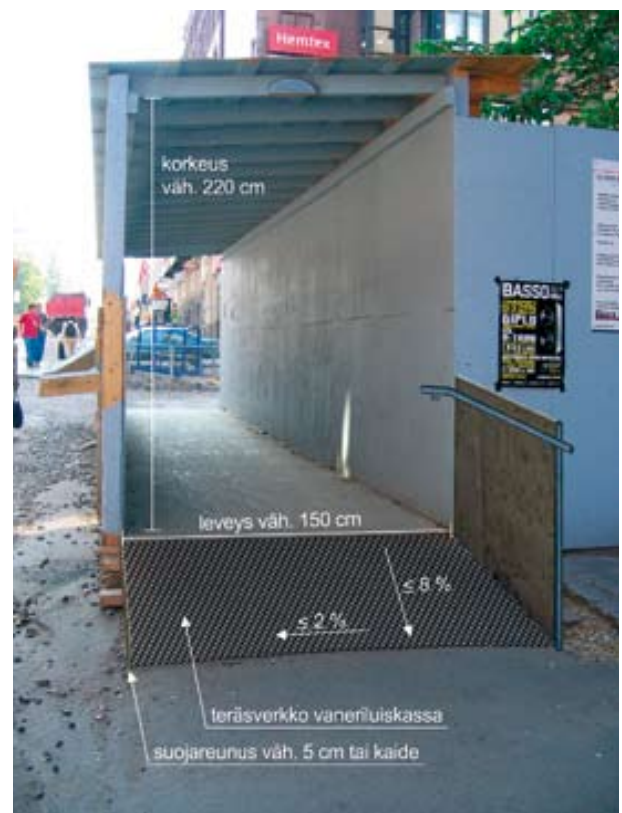
Kuva 52. Esimerkki katetusta työmaa-aikaisesta jalankulkuväylästä ja luiskasta. Luiskan sivuseinäke ohjaa kulkijan selkeästi pois ajoradalta. Teräsverkko vaneriluiskassa toimii talviolosuhteissa. (Kuva: SuRaKu)
