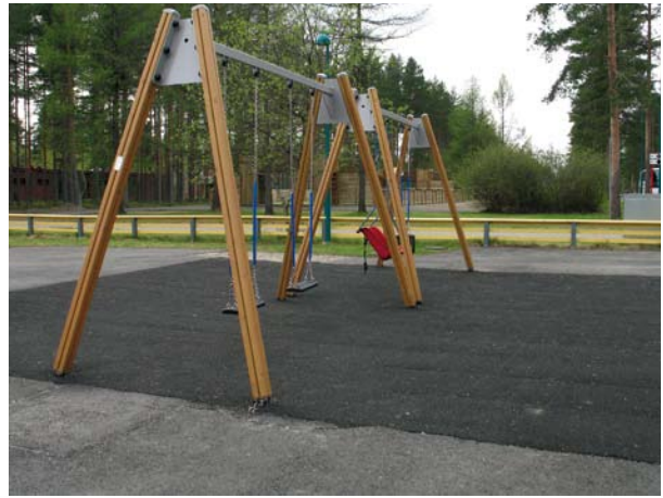
Kuva 46. Keinujen sijainti sekä keinutelineen runko erottuvat tummuuskontrastina taustasta. (Honkalampi Säätiön esteetön lähiliikuntapaikka, Honkalampi. Kuva: AR)
