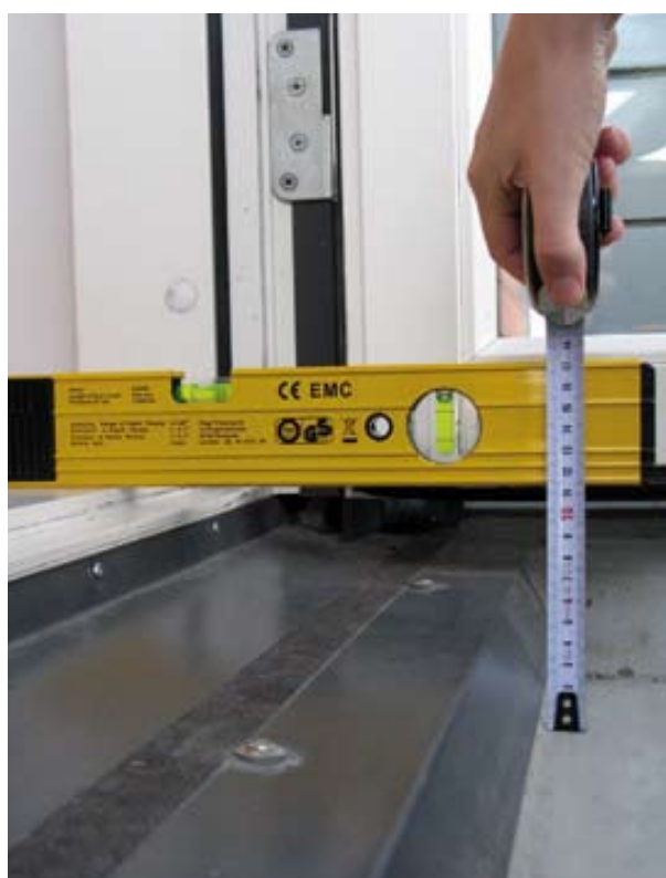
Kuva 57. Kynnyksen korkeuden mittaaminen sujuu helposti kaltevuusmitan avulla. (Kuva: AR)
