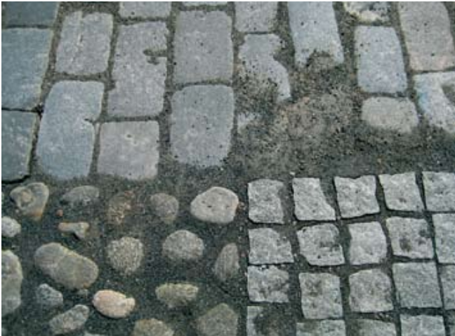
Kuva 33. Kulkuväylän pintamateriaaliksi eivät sovi nupukivi (ylh.), mukulakivi (alh. vas.) ja noppakivi (alh. oik). (Kuva: AR)
