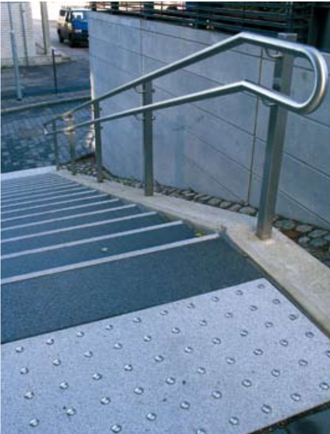
Kuva 36. Erikoistason esteettömissä ulkoportaissa on varoitusalue ennen portaita, selkeät kontrastiraidat askelmien etureunoissa ja oikein mitoitettu käsijohde. (Esteettömien ympäristötuotteiden kehityshankkeen (ELSATUOTE) koekohde, Rajapaadenpolun luonnonkiviportaat, Vuosaari, Helsinki. Kuva: AR)
